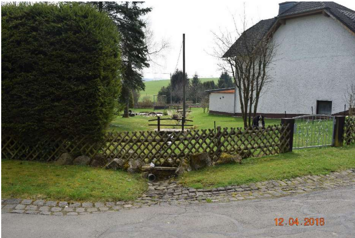
Abb. 6: Kradenbach nach Auslass aus der Verrohrung und Notabfluss Hauptstraße
